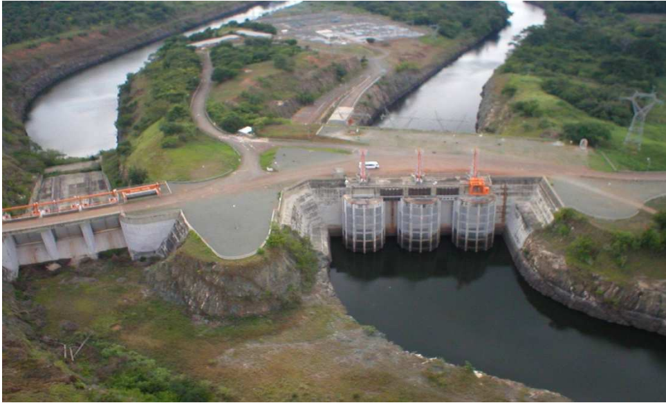
Le barrage de Kossou vu d'en haut
