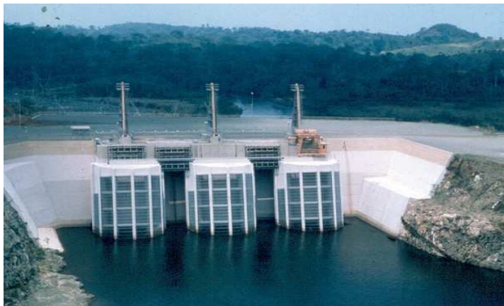
Prise d'eau du barrage
